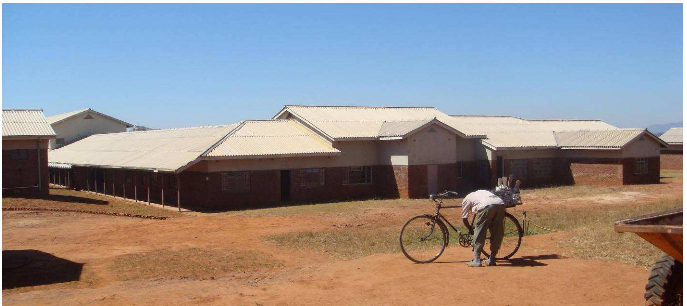
Das neue Howard Hospital – seit mehreren Jahren praktisch fertig, bis heute aber noch nicht in Betrieb
